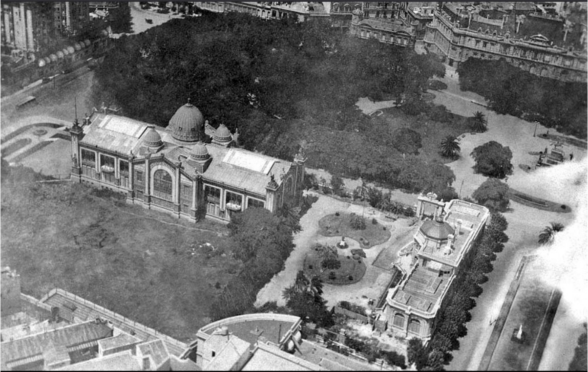
Anexo 5 – El Pabellón armado en la calle Arenales y a su derecha la confitería, en la esquina sobre la calle Maipú
